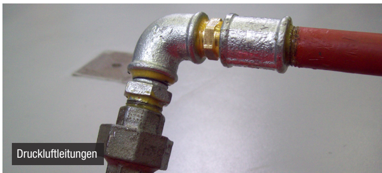
Undichte Dehnschrauben
